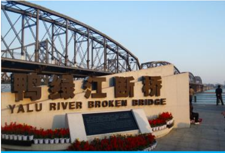
สะพานขาด
