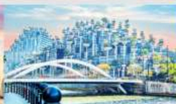
อาคารฟันทันไม
